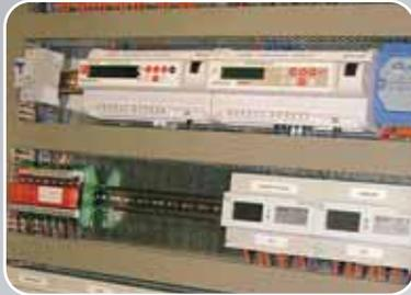
**Multifunktionales** Lastoptimierungsgerät zur Optimierung des  $\frac{1}{4}^h$  Lastverlaufes und EVU-Bezugsdatenerfassung (kW u. kWh), kompakte Bauweise für einfache Einbindung in neue und bestehende Verteilungseinrichtungen
